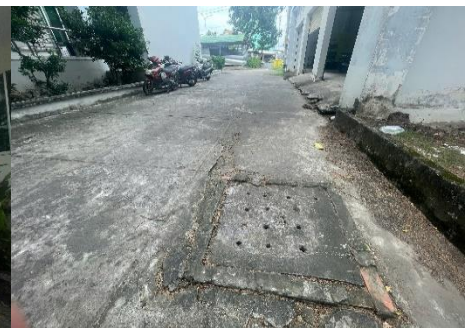
Hình 1.9. Hồ ga thu gom và thoát nước thải
